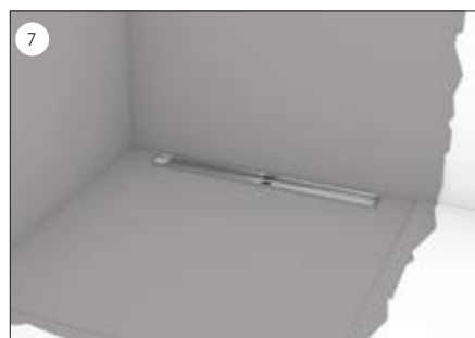
Nach dem vollständigen Aufbringen der Verbundabdichtung...
