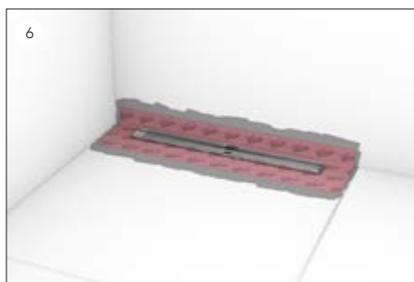
... und die Dichtmanschette einglegt.
